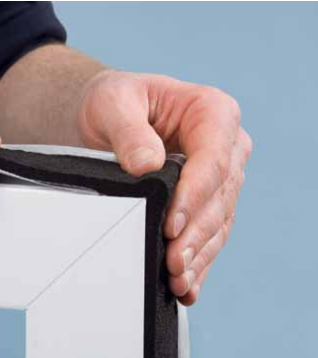
ISO-BLOCO One wird mittels Schlaufenbildung um die Fenstercke herumgeführt
