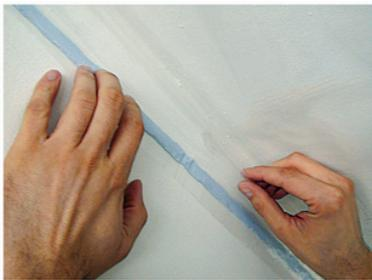
2. Entlastungsschleife in Dampfsperre legen, da diese Baubewegungen aufnimmt.
