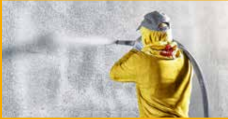
BETONSCHUTZ UND INSTANDHALTUNG
