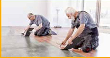
FLIESEN-, WAND- UND FUSSBODENTECHNIK
