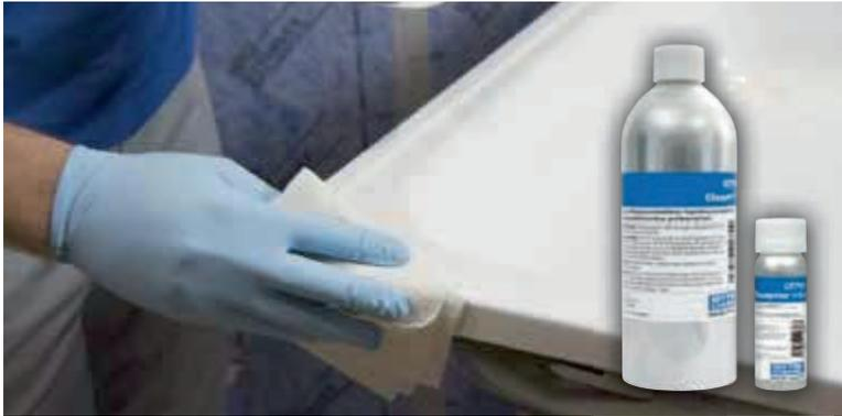
Zur Abdichtung der Duschwanne müssen die Ränder zunächst entweder mit OTTO Cleaner T gereinigt werden oder mit OTTO Cleanprimer 1101 in einem Arbeitsgang gereinigt und geprimert werden.
