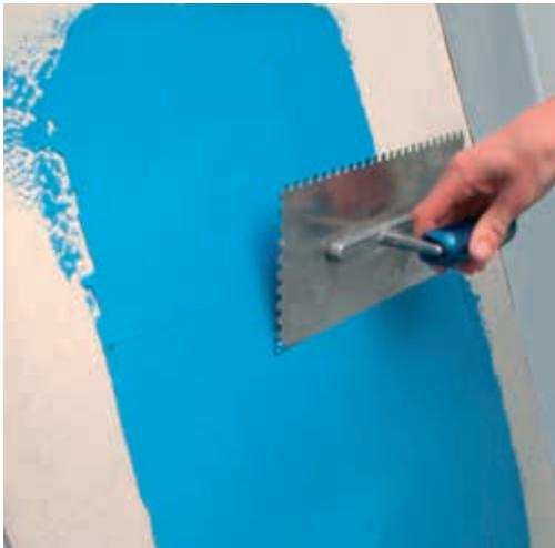
Die Menge des Auftrags muss mit einem Schichtdickenzuschlag erfolgen, damit eine Trockenschichtdicke von 0,5 mm nicht unterschritten wird. Dies erfordert eine Nassschichtdicke von mind. 0,7 mm. Ein Schichtdickenzuschlag von 25 % ist nach DIN 18534-3 bei unebenen Oberflächen zuzurechnen.
