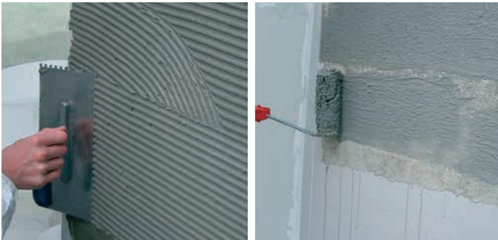
Beim Aufbringen der OTTOFLEX Dichtungsschlämme mit einer Zahnschachtel ist ein zweimaliger Auftrag erforderlich, um die benötigte Trockenschichtstärke von 2mm zu erhalten. Wird die OTTOFLEX Dichtungsschlämme mit einem kurzflorigen Lammfellroller aufgetragen, sind drei Schichten nötig, um eine Trockenschichtstärke von 2 mm zu erhalten. Ein Schichtdickenzuschlag von 25 % ist nach DIN 18534-3 bei unebenen Oberflächen zuzurechnen.
