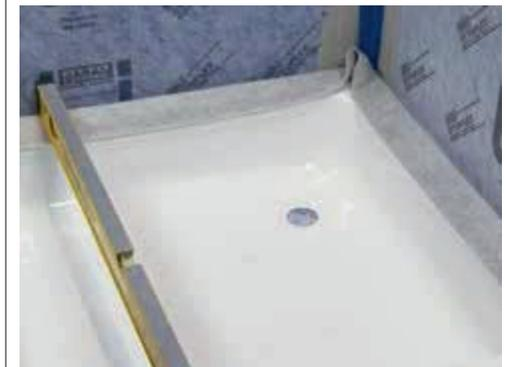
Randbereich der Dusche/Wanne mit Krepp-Band schützen, um Verschmutzungen vorzubeugen. Das OTTOFLEX Wannenranddichtband nach innen klappen und Dusche/Wanne installieren.
