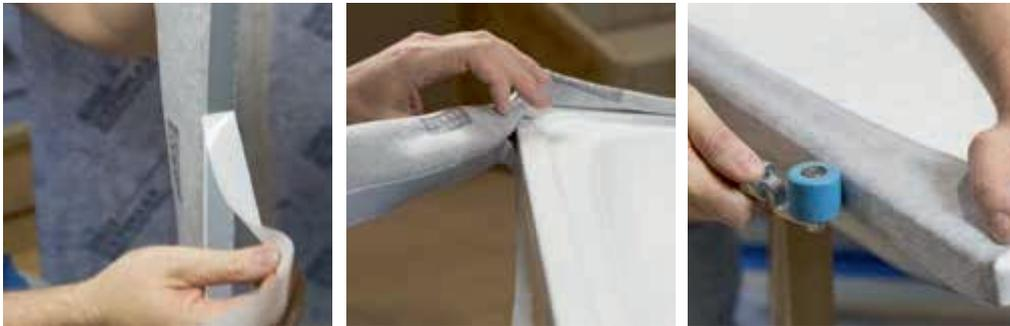
Anbringen des OTTOFLEX Wannenranddichtbandes ohne Falten und Luftblasen. Das OTTOFLEX Wannenranddichtband mit einem Roller fest anpressen.
