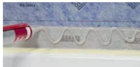
Das OTTOFLEX Wannenranddichtband mit OTTOCOLL® M500 wasserdicht überarbeiten.
