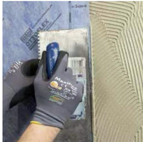
OTTOFLEX Abdichtbahn vollflächig an den Kleber andrücken. Zum Eindrücken empfiehlt sich die Glattseite der Zahnpachtel oder eine Glättspachtel, die unter Druck schräg über die OTTOFLEX Abdichtbahn geführt wird. Lufteinschlüsse und Falten müssen unbedingt vermieden werden.
