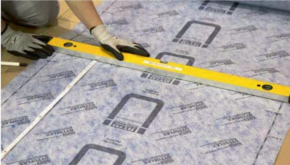
Die OTTOFLEX Abdichtbahn auf gewünschtes Format zuschneiden. 5 cm Überlappung dabei dazu rechnen.
