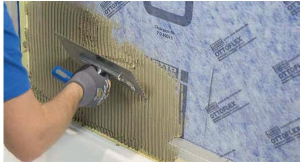
Wenn die OTTOFLEX Abdichtbahn mit allen Überlappungen, Ecken und Anschlüssen dicht verklebt ist, kann mit dem Aufbringen des Fliesenbelags begonnen werden. Eine Wartezeit ist nicht erforderlich. Zur Fliesenverlegung im Dünnbettverfahren ist der Fliesenkleber direkt auf die OTTOFLEX Abdichtbahn aufzutragen.
