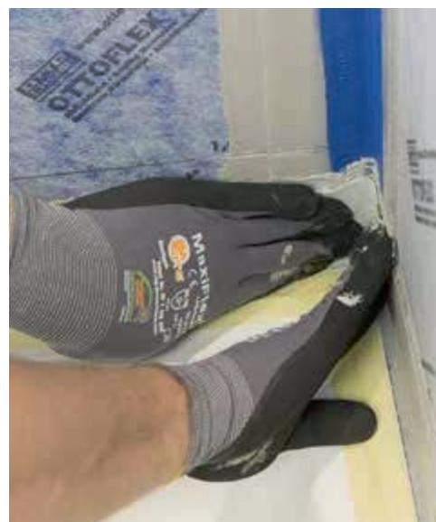
Das Eck ausformen, dabei mit den Händen das OTTOFLEX Wannenranddichtband in die Ecke schieben. Das OTTOFLEX Wannenranddichtband ist dehnbar und lässt sich somit perfekt in die Ecke pressen.
