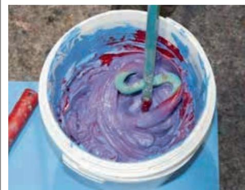
Mischen der Flüssigfolie bis homogene Farbe entsteht
