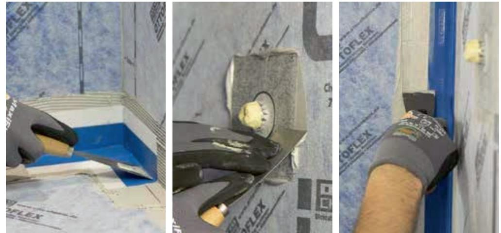
Für Innen- und Außenecken, Kanten sowie an Rohrdurchführungen können die Produkte aus dem OTTOFLEX System verwendet werden (Innen-/Außenecke, Dehnzone, - Bodendichtmanschette sowie Dichtband). Diese müssen vollflächig mit OTTOCOLL® M500 verklebt werden. Das Einbringen dieser OTTOFLEX Produkte erfolgt nach Verarbeitung der OTTOFLEX Abdichtbahn.
