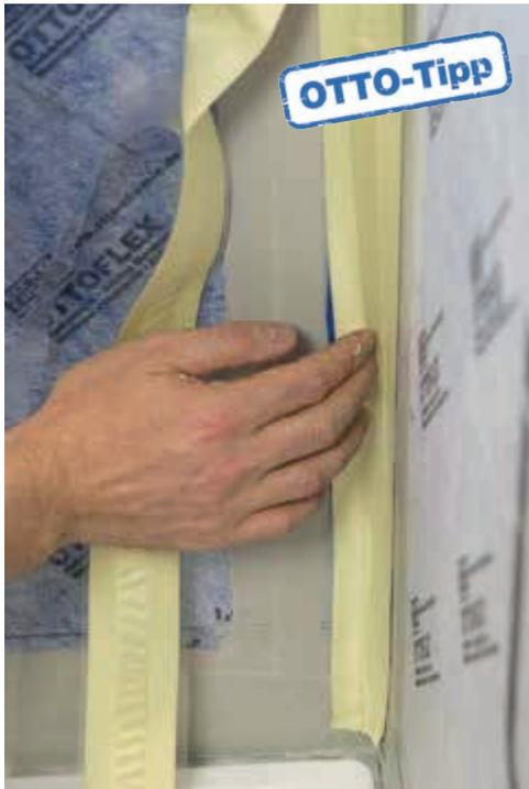
Das OTTOFLEX Schutzband wird vor dem Aufbringen des Fliesenbelags eingeklebt. Das OTTOFLEX Schutzband ist selbstklebend, daher ist kein zusätzlicher Klebstoff erforderlich. Das dünne Gewebe trägt kaum auf und ist sehr flexibel und einfach zu verarbeiten.
