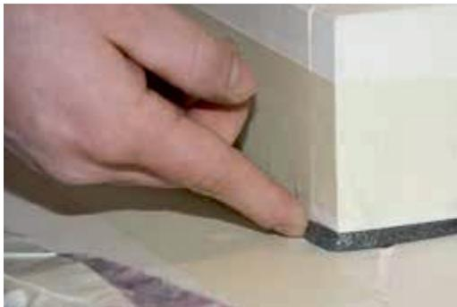
**2. Hinterfüllen** der Fuge mit der passenden Größe der OTTOCORD PE-B2 Rundschnur. Die Rundschnur muss von der Größe so gewählt werden, dass sie mit einem gewissen Druck eingebracht werden muss. Dabei ist darauf zu achten, dass die Rundschnur selbst nicht beschädigt wird. Nur so ist gewährleistet, dass die Fuge komplett ausgefüllt und die Fugentiefe somit begrenzt ist.
