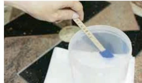
Bei Pinselauftrag ausschließlich den Fugendichtstoff gezielt mit einem sauberen Pinsel mit wenig Glättmittel (oder wenig OTTO Marmor-Silicon-Glättmittel bei Natursteinbelägen) benetzen und Fugendichtstoff anschließend mit Glättwerkzeug abziehen und glätten.
