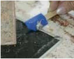
Mit der jeweils passenden Kante wird das mit Glättmittel benetzte OTTO Glättwerkzeug mit gleichmäßigem Druck über die verfüllte Fuge gezogen.
