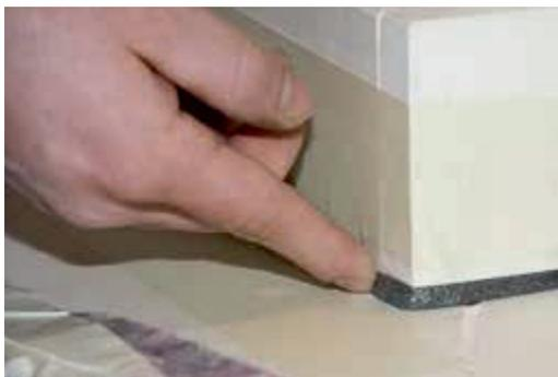
**2. Hinterfüllen** der Fuge mit der passenden Größe der OTTOCORD PE-B2 Rundsnur. Die Rundsnur muss von der Größe so gewählt werden, dass sie mit einem gewissen Druck eingebracht werden muss. Dabei ist darauf zu achten, dass die Rundsnur selbst nicht beschädigt wird. Nur so ist gewährleistet, dass die Fuge komplett ausgefüllt und die Fugentiefe somit begrenzt ist.
