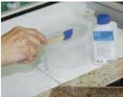
Danach wird das OTTO Glättwerkzeug wieder benetzt und die Fuge in der genannten Technik weiter geglättet. Nach dem Glätten müssen die auf den Fliesen oder Platten verbliebenen Rückstände des Glättmittels entfernt werden, um Fleckenbildung zu vermeiden. Das Ergebnis ist eine perfekte Fuge.
